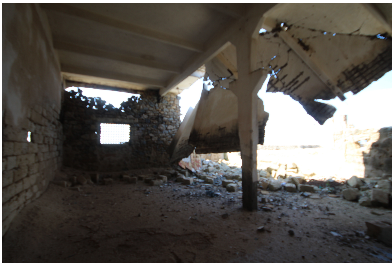
Fig. 5. Condizioni attuali del capannone.
