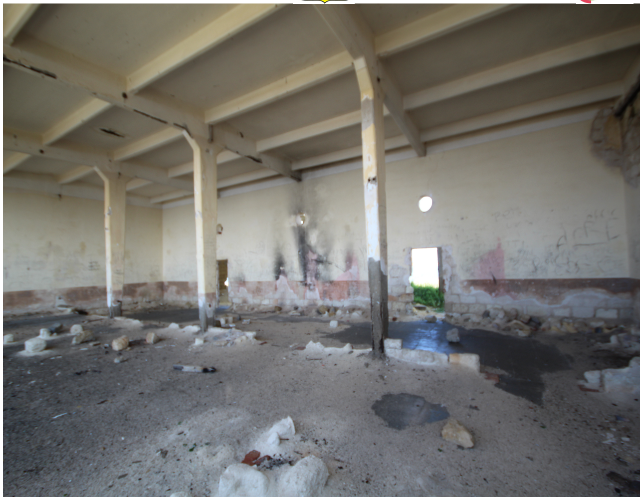
Fig. 7. Condizioni attuali del Capannone.
