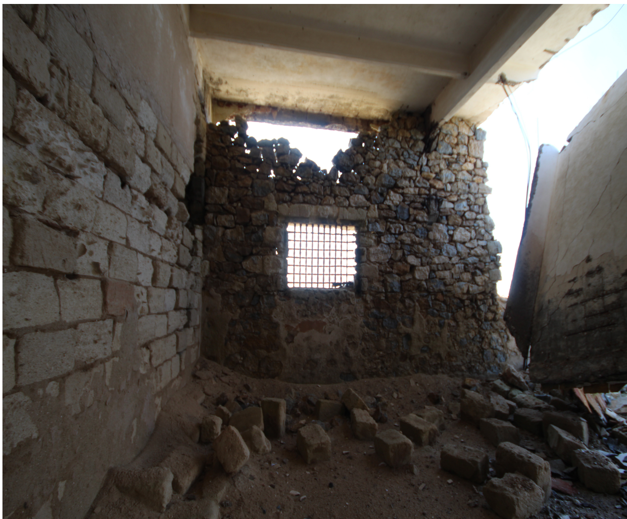
Fig. 6. Condizione attuale del capannone.
