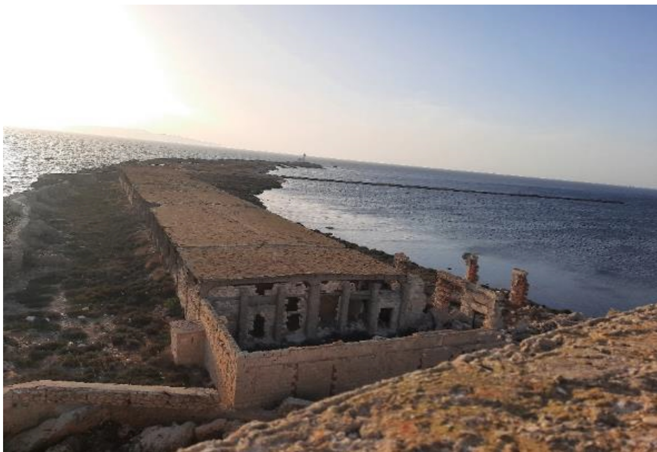
Fig. 4. Scogliera e Capannone allo stato attuale
